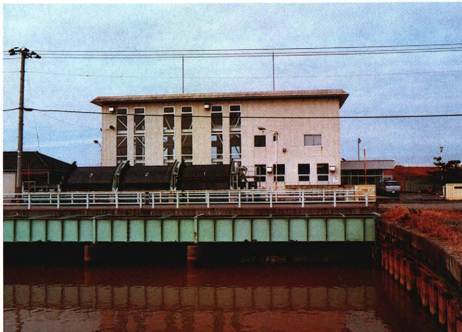
田上郷排水機場 (55年完成)
