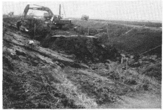
写真-1 掘削施工状況
