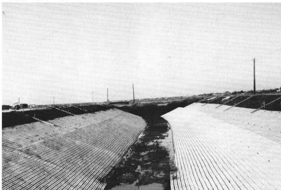
ブロックマット完了直後状況
