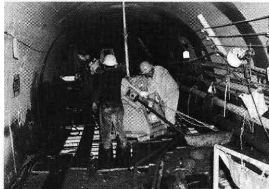
写真-2 薬液注入工
