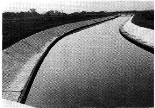
写真-4 完成(施工後)
