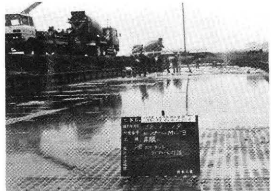
写真一2 コンクリート打設状況
