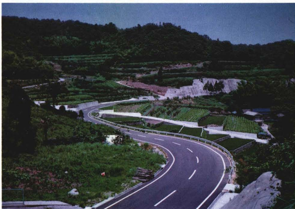
写真-3 足付コンクリート打設
