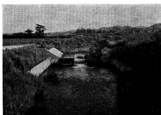
写真二 魚道付落差工 (S55年施工)
