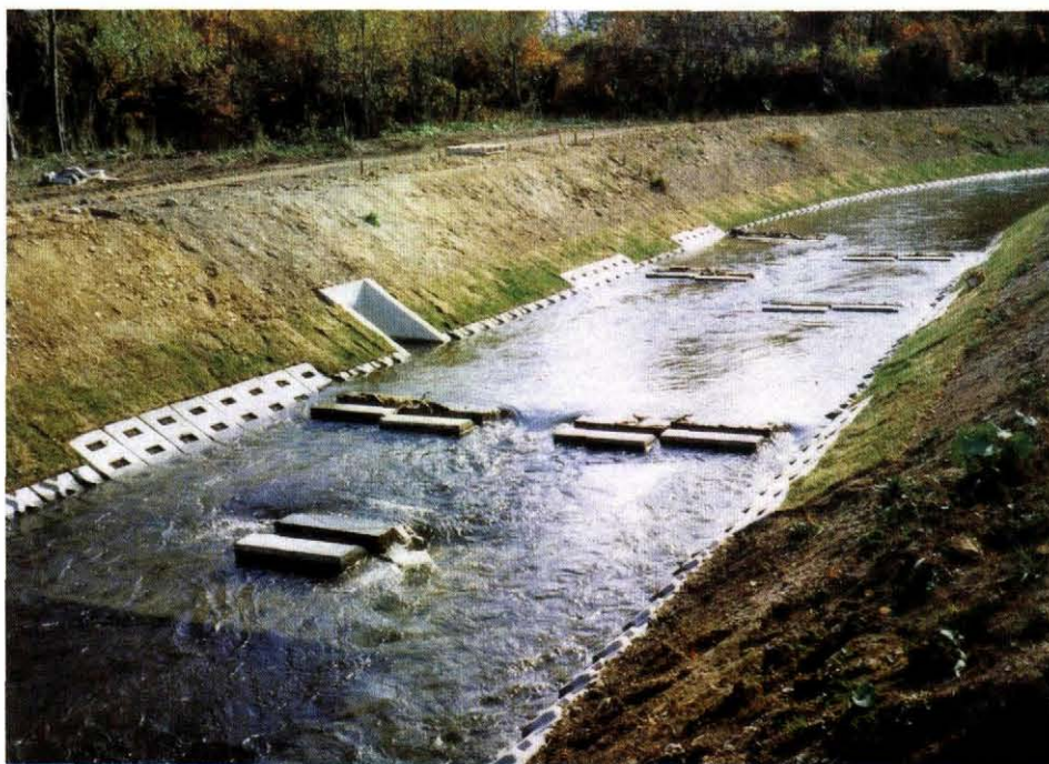
写真-5 棲息ブロック配置状況 (手前はAタイプ、後方はBタイプ)
