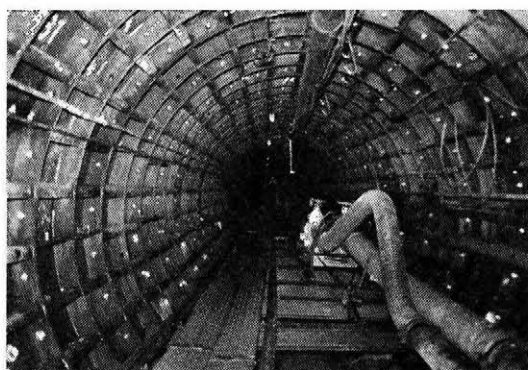
写真一3 1次覆工完了
