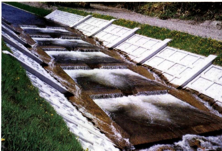
写真-3 階段式落差工 (S 56年施工)
