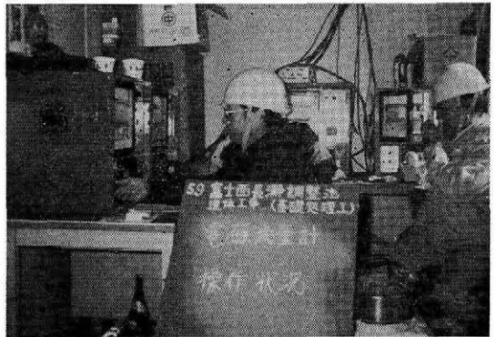
写真-4 「グラウト注入管理室」
