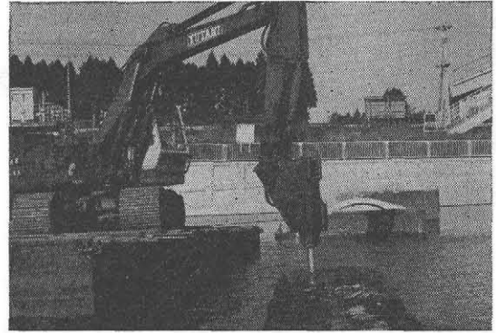
旧堰撤去の状況
