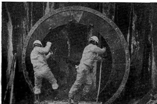
写真-1 鏡切断整形
