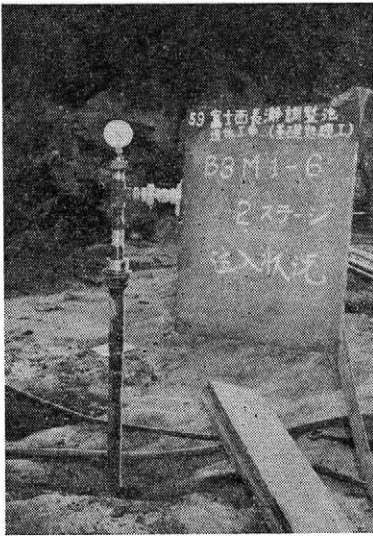
写真-6 「グラウト注入状況」
