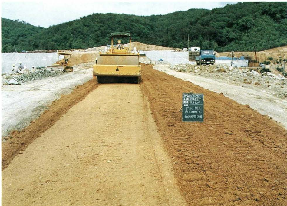
▼遮水ゾーンの転圧
