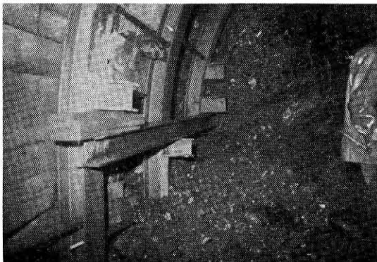
写真一五 天秤材取付状況
