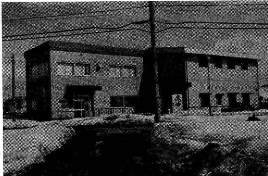
写真-1 (左側…中央管理棟, 右側…大島揚水機場)
