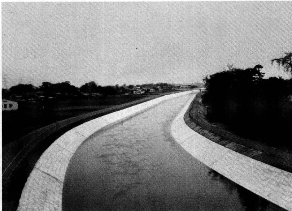
見沼代用水路 (改修後)
