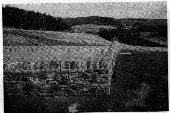
写真-4 キルダダムパラペット
