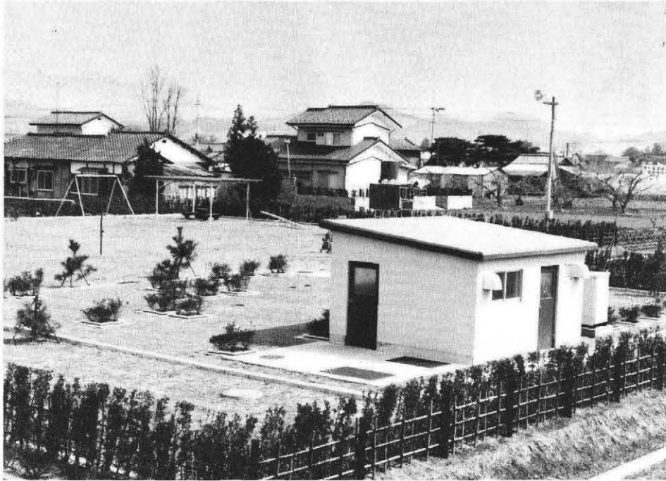
△汚水処理施設
