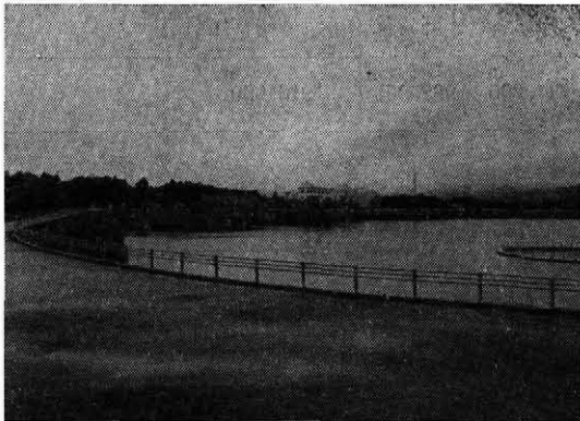
写真-1 東原調整池
