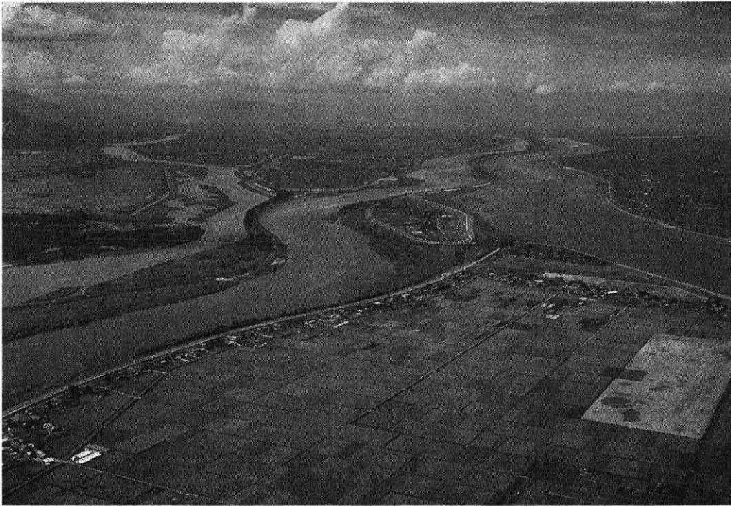
写真-1 木曾三川全景
