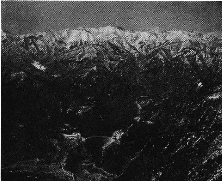
写真 矢木沢ダム (利根川水系最大のアーチダム)
