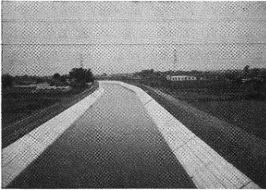
写真一六 改修後の星川区間
