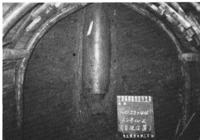
立坑とトンネル
