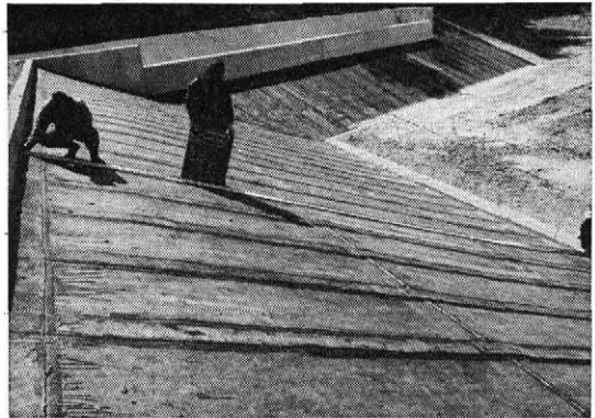
写真一7 アルファルトパネル張付完了
