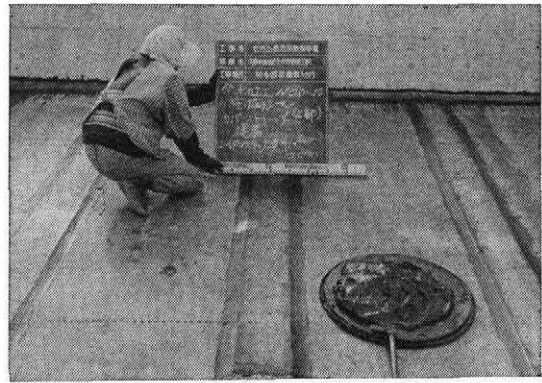
写真一6 カバーストリップ接着完了
