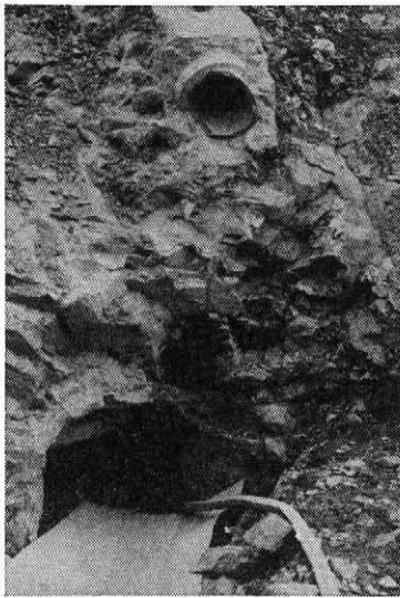
写真—5 現況取水トンネルの入口
