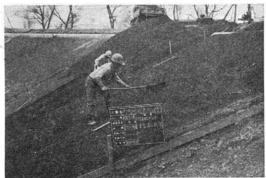
写真-8 ソイルセメントまき出し工
