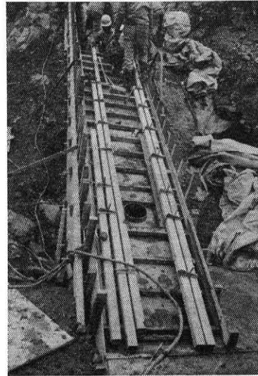
写真一八 コンクリートの打設
