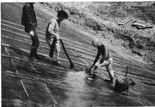
写真一5 パットジョイント施工中
