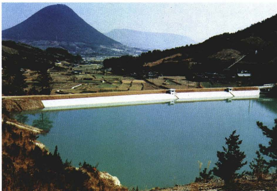
香川県・奥池下池
