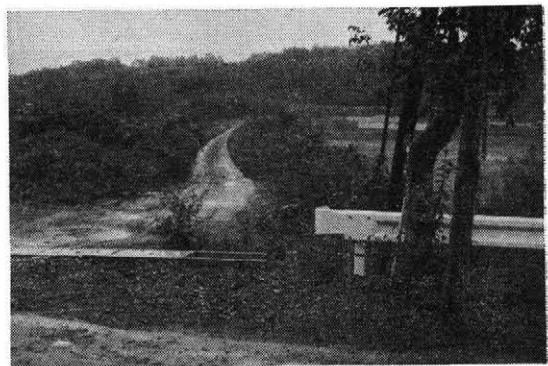
写真二 現況……左岸より余水吐（改修後）を望む
