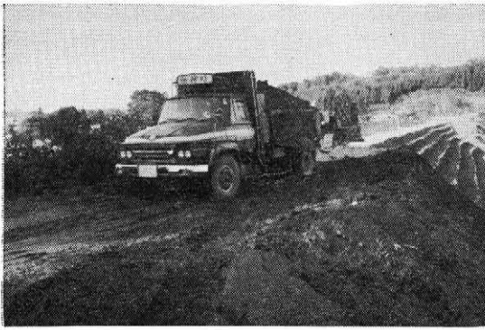
写真-3 堤体盛土工
