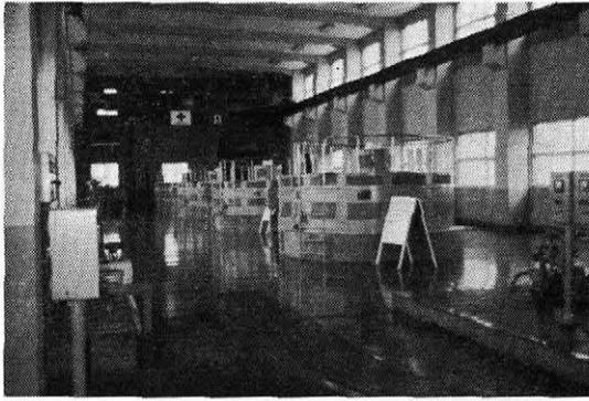
写真一 2 南部機場の排水機手前が口径2,200mm
