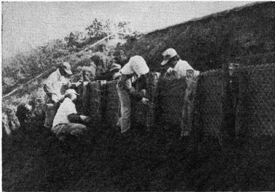
写真一4 土留柵工（土中埋設）の施工
