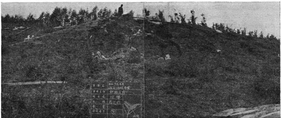
写真—3 洞爺湖周辺地区の被害
