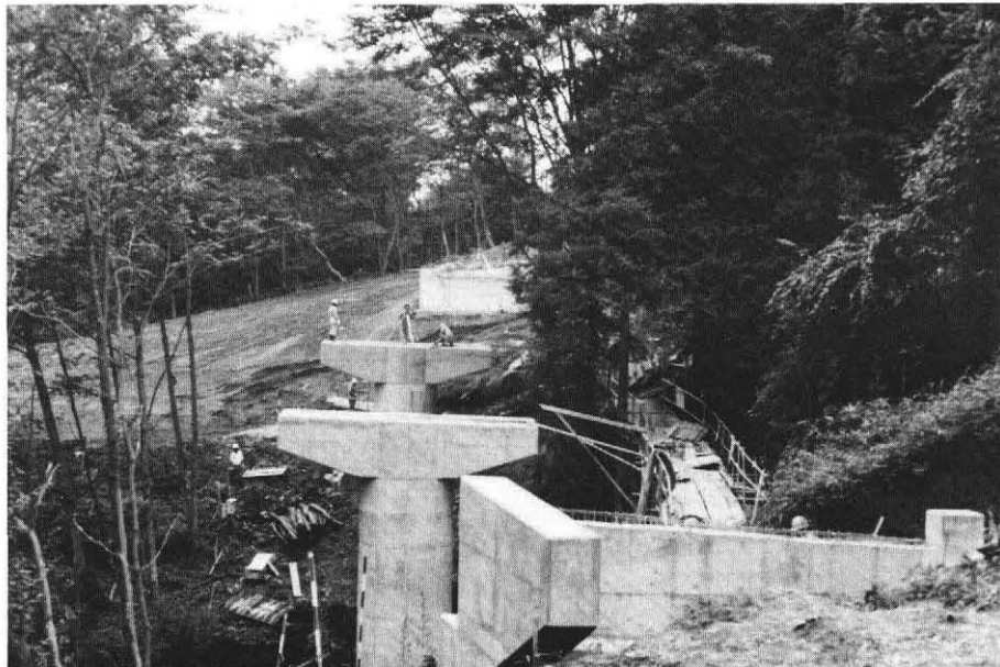
写真-2 コンクリート打設
