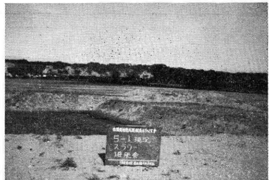
写真一七 各建物建設敷のバックドレーン施工部に二次盛土、プレロード盛土の載荷放置中の状況
