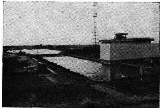
写真一 利根大堰取水状況（最大取水量約137m 3 /s）
