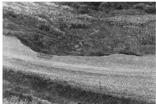
写真—7 道路盛土部崩壊状況 (農用地開発事業 中空知地区 第2号幹線道路)
