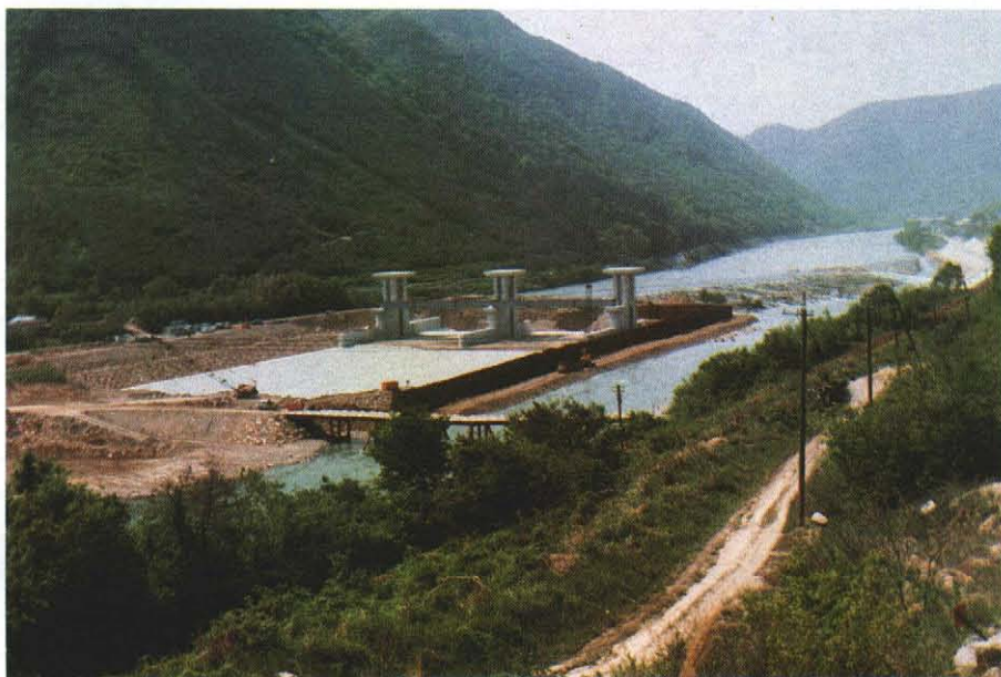
施工中の新田原井堰全景
