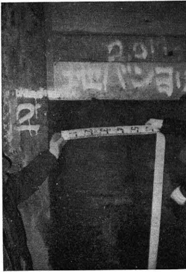
写真一４ CCP杭の仕上り
