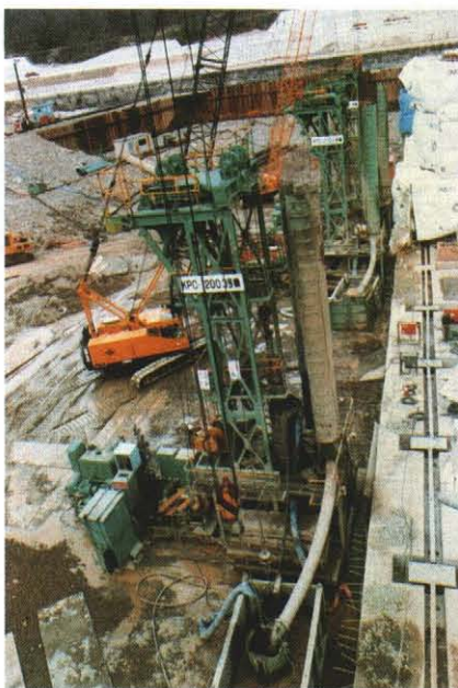
重錘掘削施工状況
