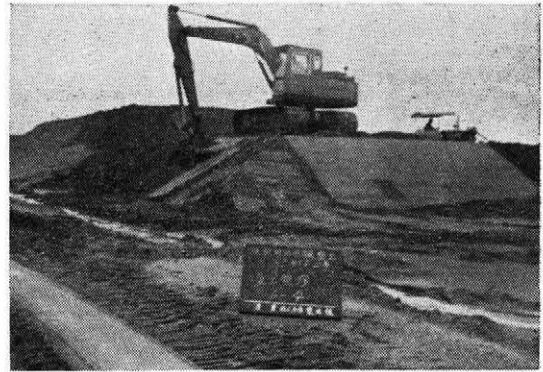
写真一四 サンドドレーン施工部の二次盛土及びプレロード盛土の載荷を行ない整形している状況
