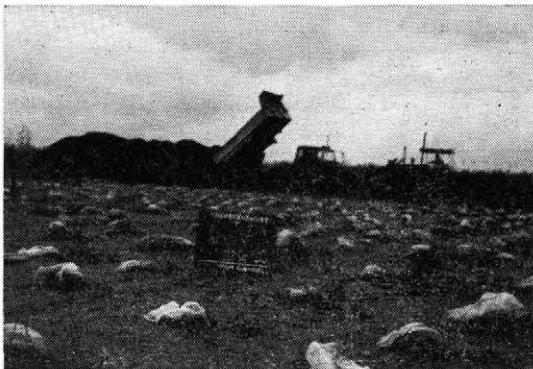
写真一六 サンドドレーン完了部の二次盛土を開始した状況
