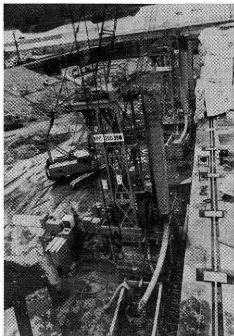
写真—2—1 重錘掘削施工状況
