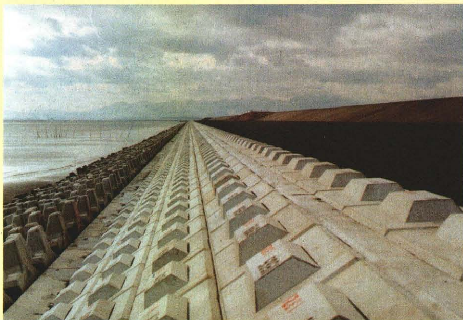
完成した前小段工
