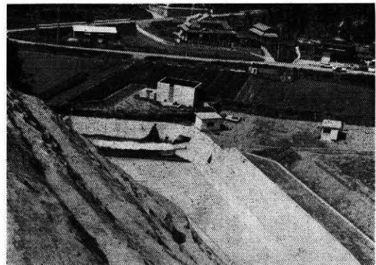
写真一 2 放流工附近全景
