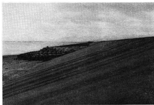
写真一四 完成した前小段工
