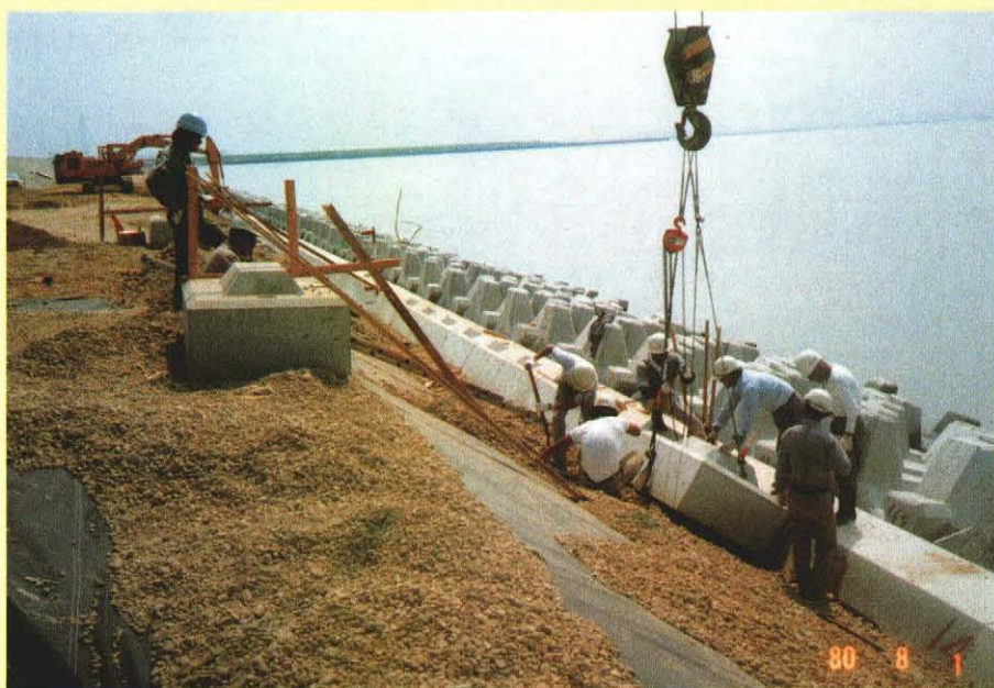
施工中の前小段上部工
