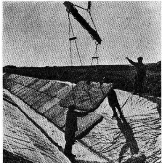
写真-1 ソ連における大型ブロックの据付け
