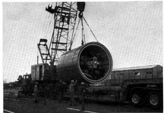
写真-1 I D300 + t 250H P 泥水加圧式セミシールド機
