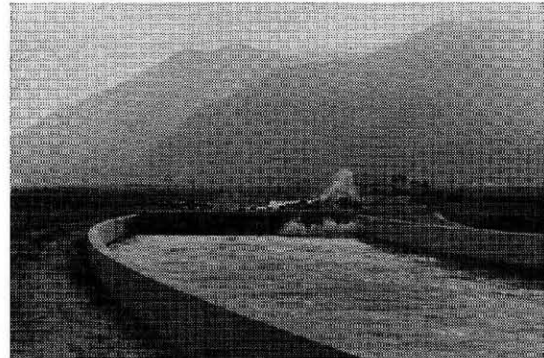
写真一 3 波返しの無い消波工における流況，流れは右下の方に向かう。消波工の上に見えるのは角材などの諸材料を置いている。
