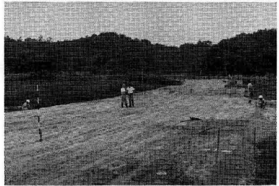
写真一6 緩速盛土施工
