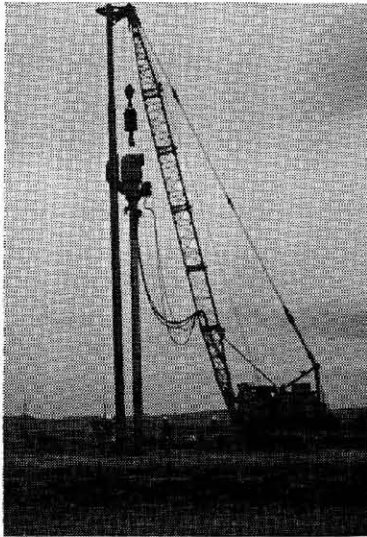
写真一4 サンドパイル打設
