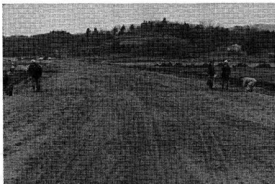
写真-3 サンドマット施工
