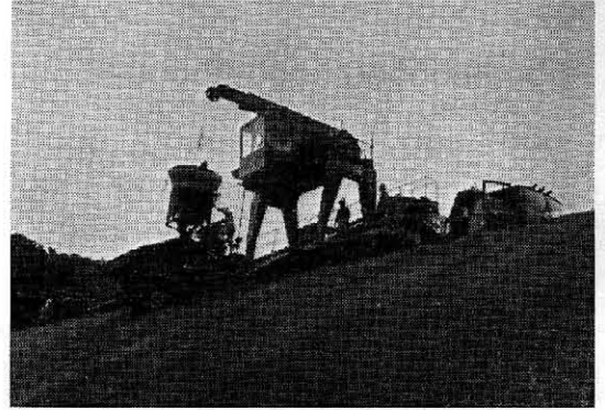
写真-3 バケットからダンパへ合材供給
