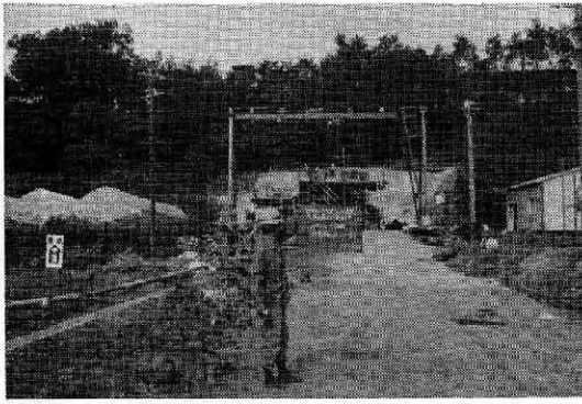
写真-2 門型クレーン2.8ton吊
