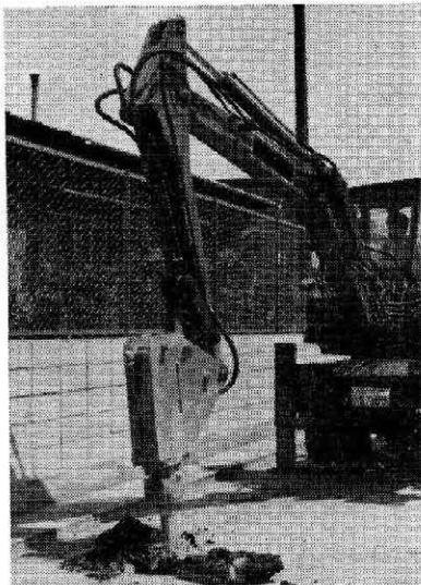
写真-Ⅲ・3 油圧ブレーカー
