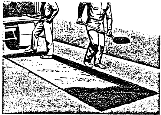
図-III・5 混合物の投入敷き均し
