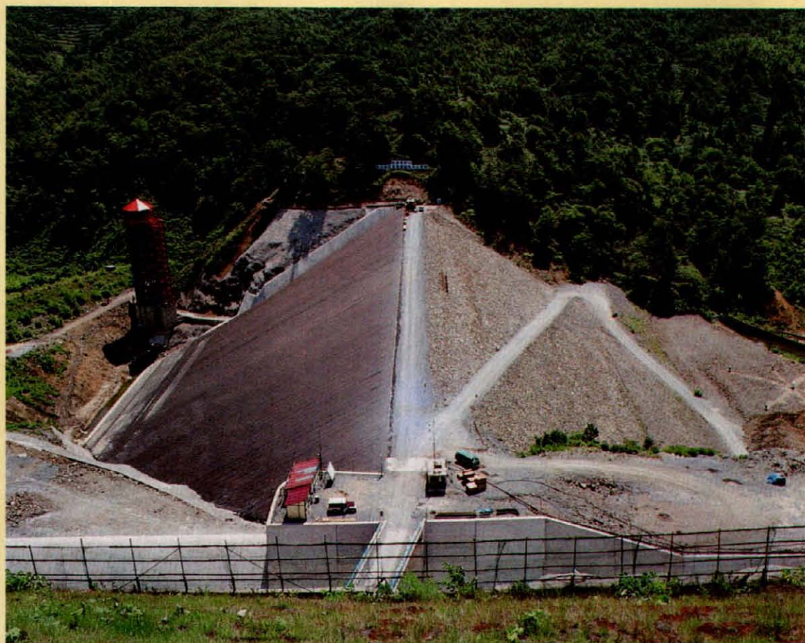
双葉ダム全景
