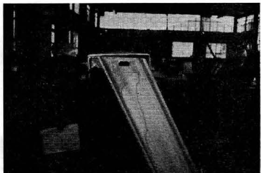
写真-4 天端に軽量ミゾ形鋼をボルトにより取付ける。
