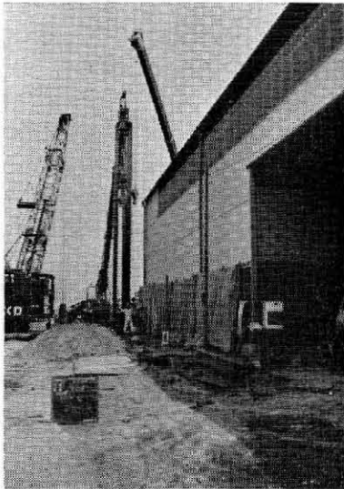
写真-2 鋼矢板引抜き状況(ℓ=15.0m)
