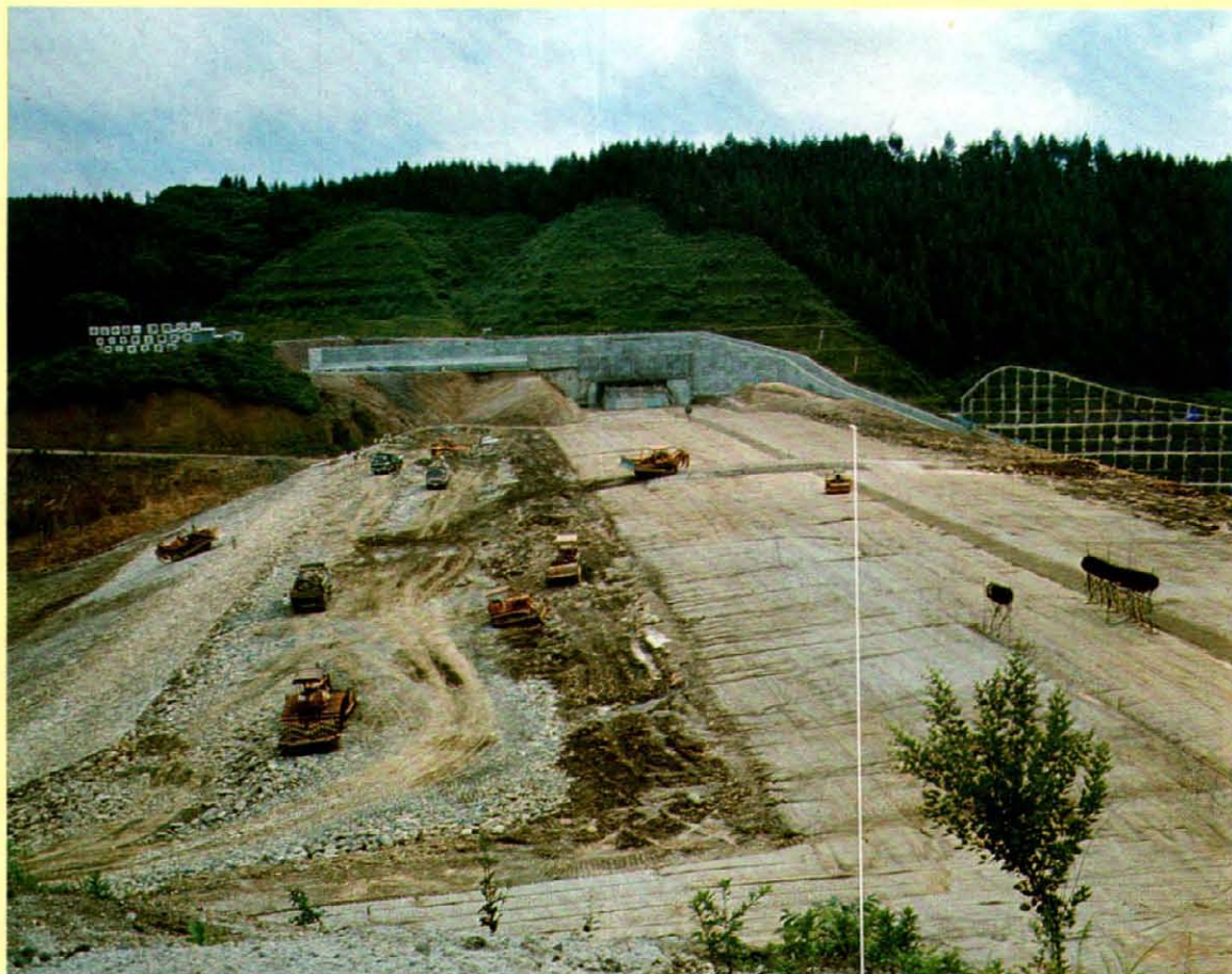
築堤工事中の浪岡ダム（右岸からのぞむ）
