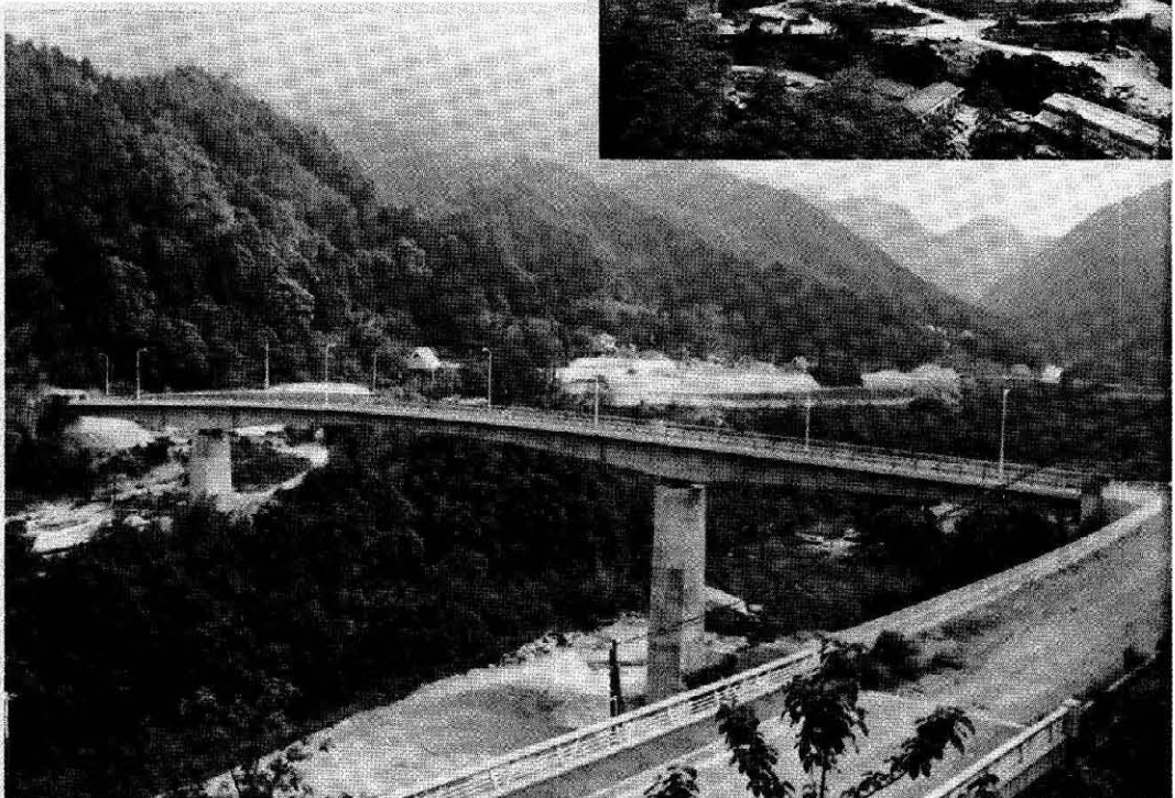
貯水池ほぼ中央部に架設された湖面橋(夕月橋)——ディビダーグ工法による橋長160メートル(3径間連続コンクリート橋)
