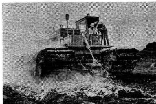
写真Ⅱ-9 石灰安定処理による施工状況
