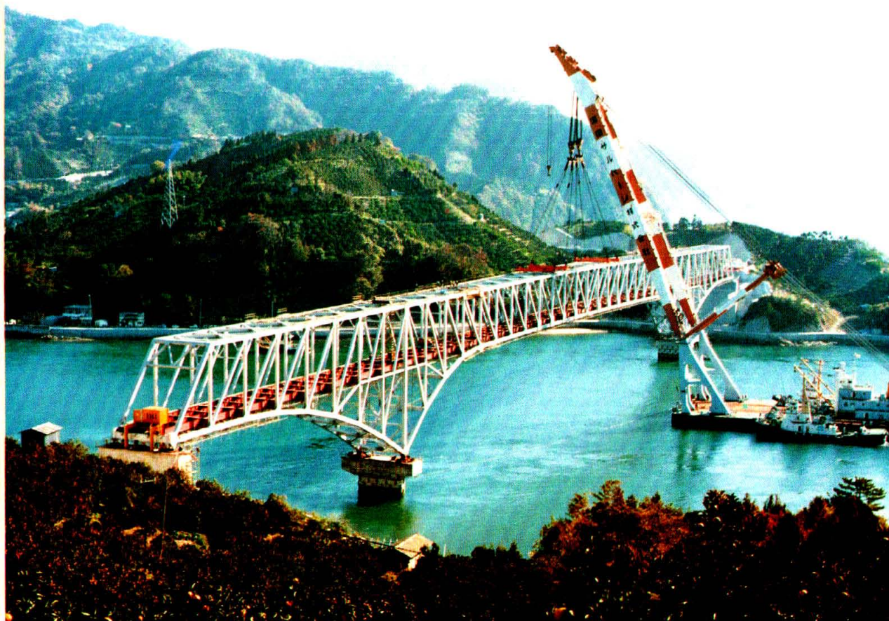
架設中の蒲刈大橋
