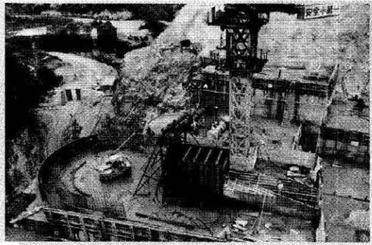
▲常用洪水吐(穴あき部)の施工状況、後方のトラスタワーは、ダムコンクリート打設用クライミングジブクレーン(200t-m)のポスト。(S54.5.25撮影)
