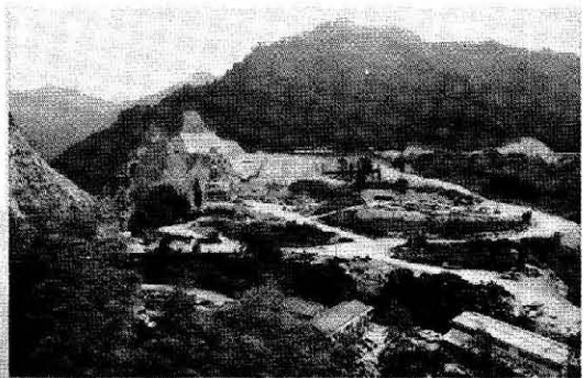
▼仮設ヤードの状況、左端V字谷が上流から望むダムサイドである。
