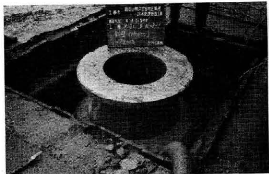
写真一4 マンホール据付
