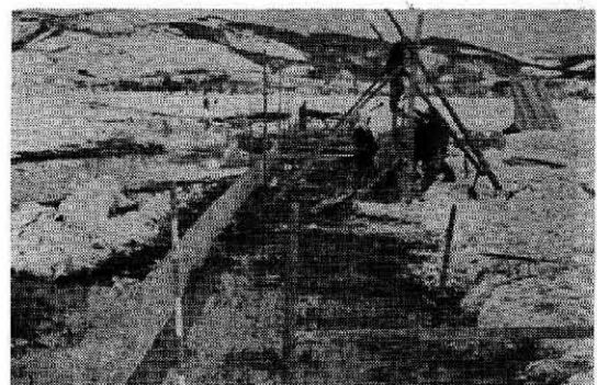
写真 II-1 移動式やぐらを用いてコルゲートプレートを正しく鉛直にさし込んでいる状況。
