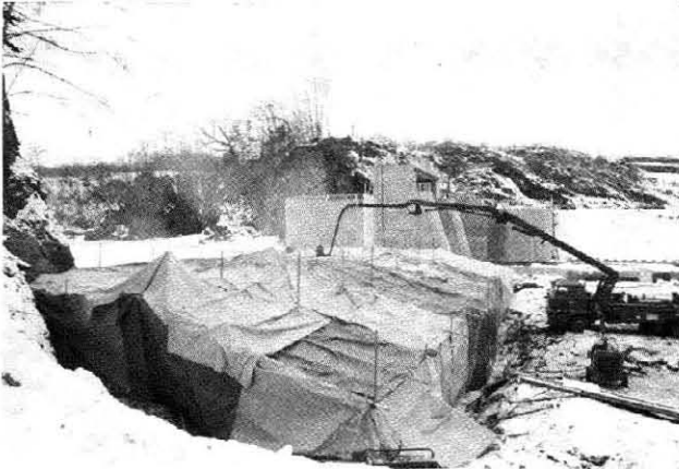
←頭首工施工状況
