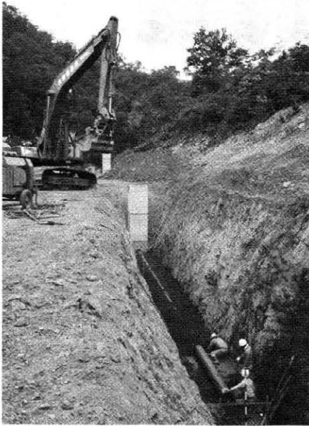
↑導水渠施工状況
