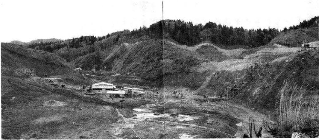
ダム堤体基礎処理全景
