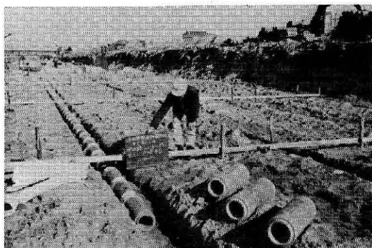
写真-5 アンダードレーン布設
