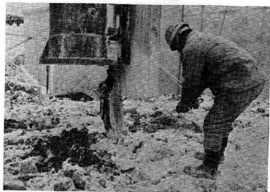
写真-2 ケーシング先端
