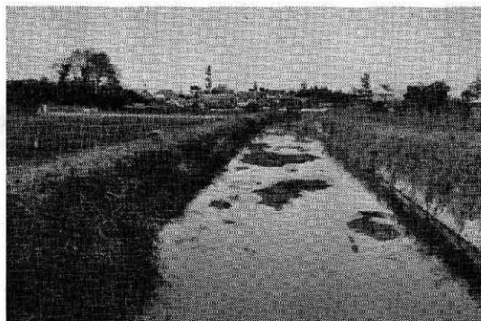
写真-2 佐屋川用水路（着工前）
