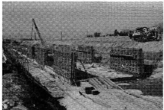
写真-7 側壁大型々枠
