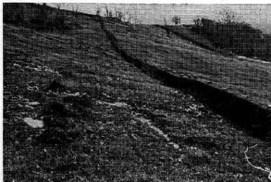
写真一3 マット柵工
