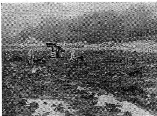
写真—7 河床砂レキ採取跡地植栽工事の状況（ダム上流河川敷内）
