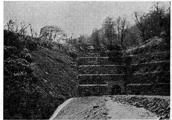
写真一二 ダム右岸部岩盤面緑化工とその成果
