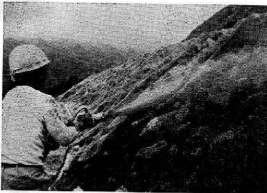
写真一七 原石山捨石のり面種子入客土吹付
