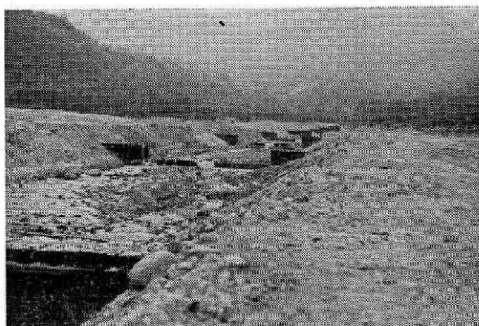
写真—6 河床レキ採取後の河道整備状況（床土工100m間隔）
