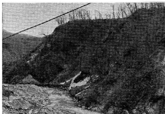
写真—13 ダム下流原石山 (施工前自然の姿)
