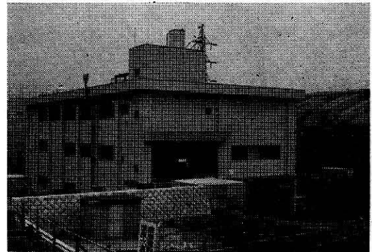
写真-1 蒲原揚水機場
