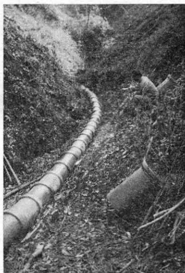
ミオスジ配管状況 (下流より)
