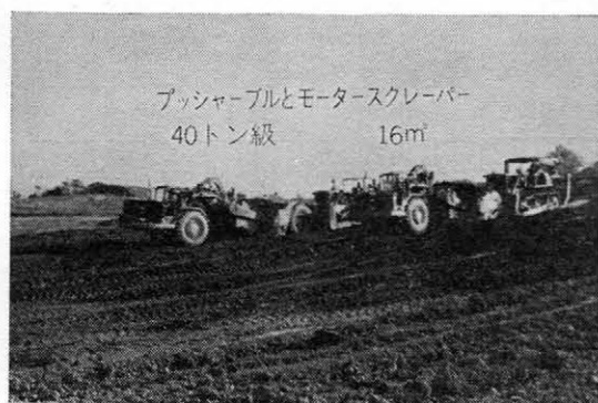
写真—2 土取場における作業状況
