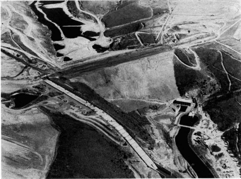
完成直後のティートンダム
