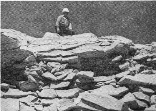
写真3 右岸側表層部付近の溶結凝灰岩の板状節理
