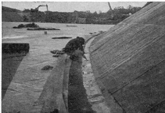
写真10 下部固定工取合せゴムシート
