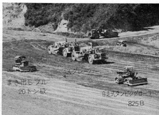
写真—3 盛土作業の状況
