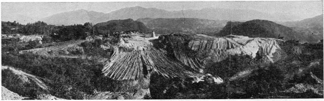
工事途中の状況
