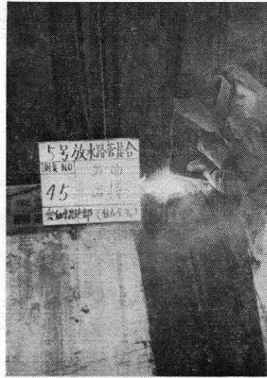
(f) 鋼管の溶接
