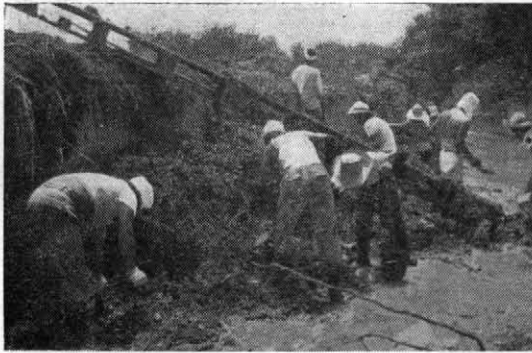
図-9 枝下幹線水路内埋土の排除作業
