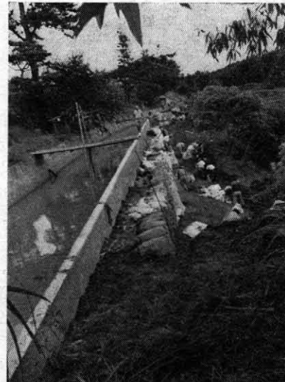
図一 8 枝下幹線水路堤塘法面崩壊カ所 の応急仮工事
