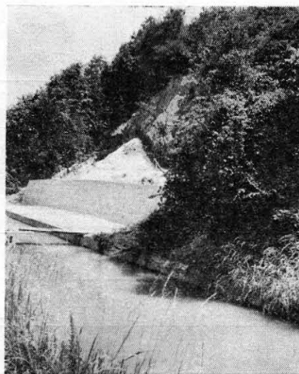
(b) コンクリートブロック張りとした山留工
