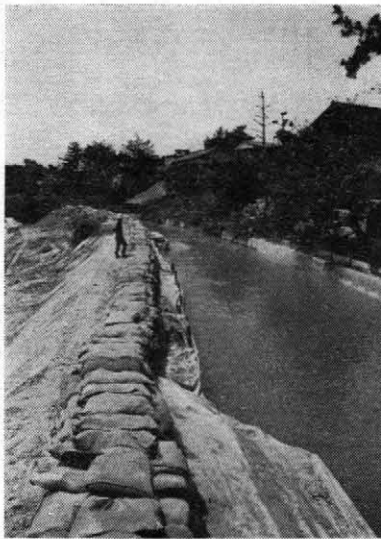
図一 7 枝下幹線水路決壊カ所の 応急仮工事
