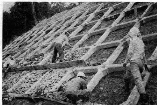
(a) コンクリート法棒工による山留工
