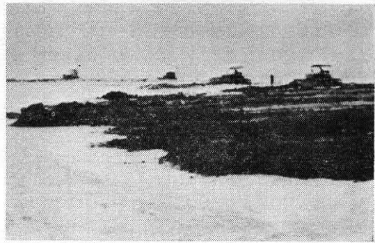
写真一7.8 雪氷マット工法
