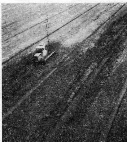
写真-7.4 排水溝堀削中のロータリートレンチャー
