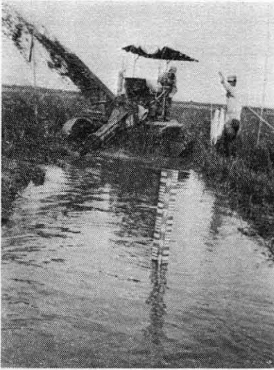
写真-7-1 排水路掘削中の小型ヨークデッチャー
