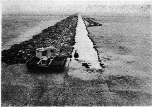
写真—4.2 マーシクラムシェルによる小排水路の荒掘削
