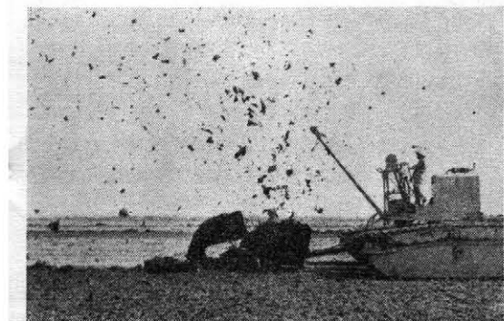
写真—5.2 マーシリーダーによるほ場面排水溝の堀削
