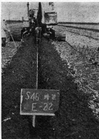
写真—4-6 ドレンマスターによる暗渠の施工（46年頃）——第2期乾燥促進工——
