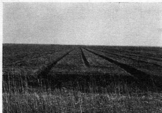
写真—4-7 クンの歯の如く施工されたほ場排水溝（47年頃）——第2期乾燥促進工——
