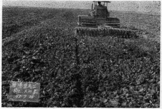
写真-5-6 ディスクハローによる砕土混和作業
