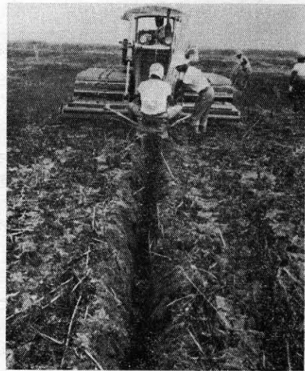
写真一7.9 人工クラック形成工法
