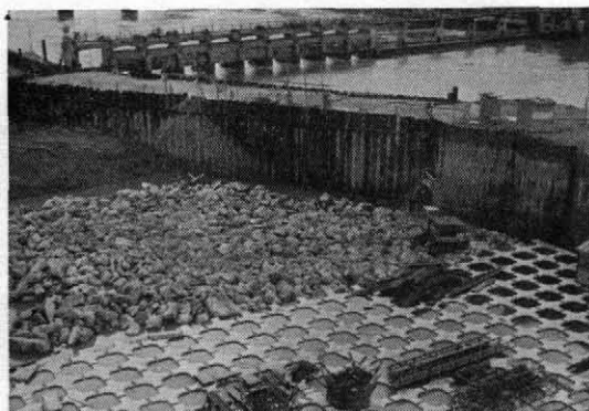
写真-13 捨石施工 (旧工区解体ガラを流用)
