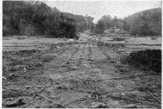
写真—2 継ぎ鉄筋とCCP杭
