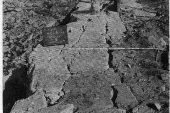
写真15 TN火薬爆破によるクラックの状況
