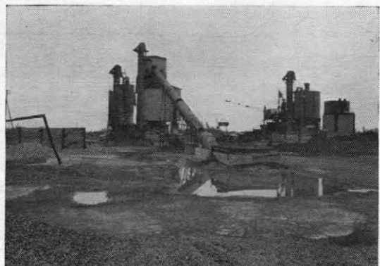
写真-3 パッチャープラント(左が 1,500 l 、右が 1,250 l )
