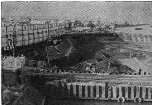
写真一七 遮音シート設置
