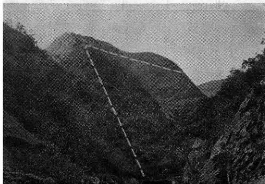
写真-11 余水吐築造前の現地, 破線は計画
