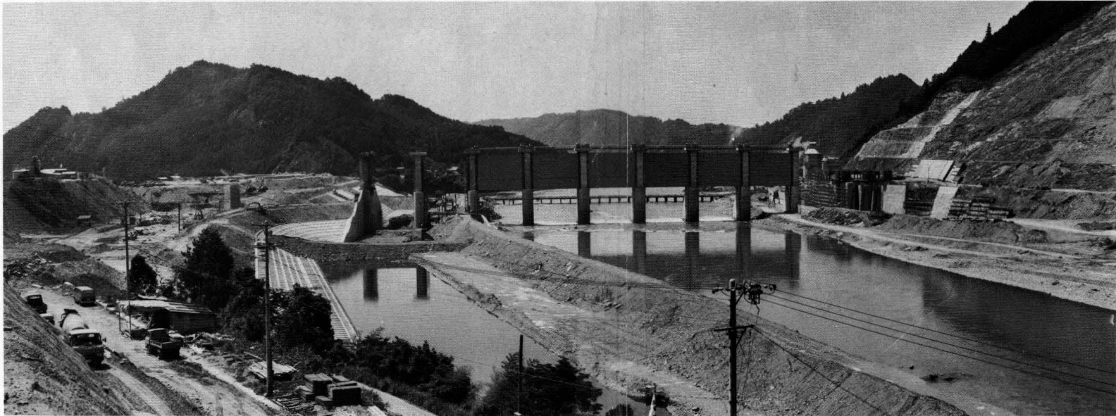
上流側よりダム地点の全景
