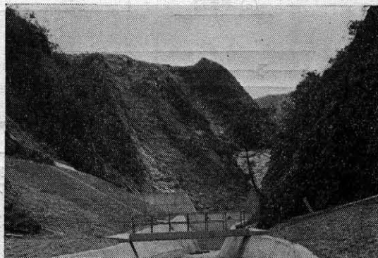
写真-12 工事中の余水吐急流部
