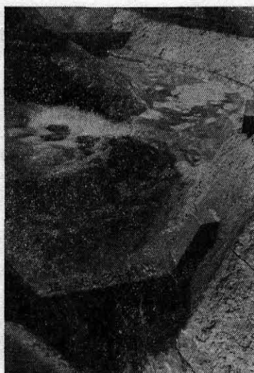
写真-9 静水池出口ゼキと堤体ノリ尻, 18.5t/s
