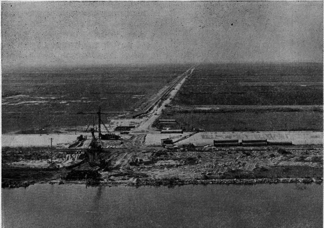
写真一 取入口、幹線用水路の工事現場を上空から望む
