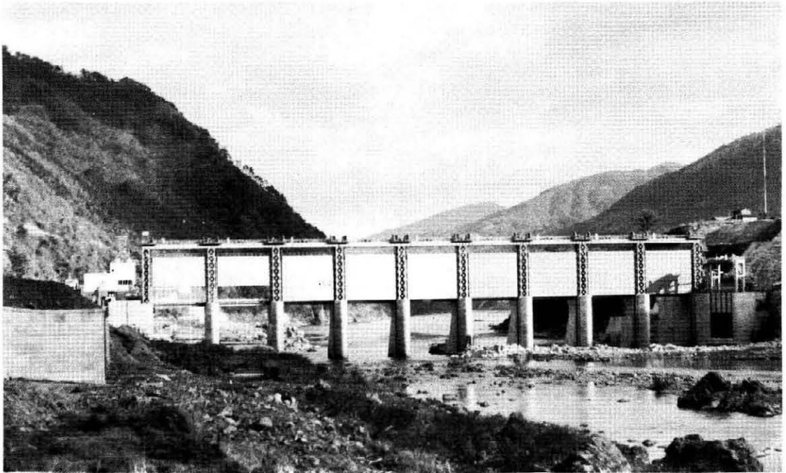
池田ダム（上流より）
