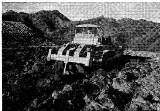
写真-1 ジャイアントリッパーによる岩掘削
