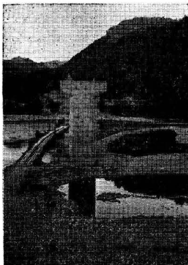
写真—3 橋脚完成写真
