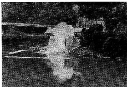
写真-1 水中発破の瞬間、気泡はエアバブルカーテン
