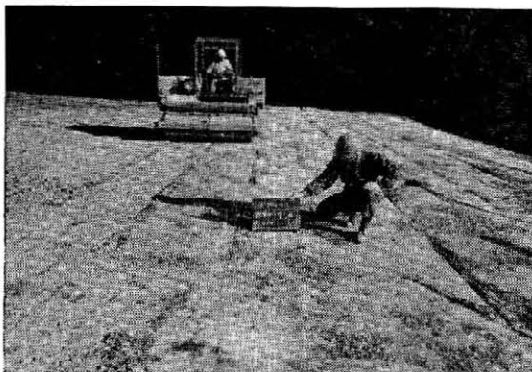
写真-3 BOMAG, BW-200 による転圧
