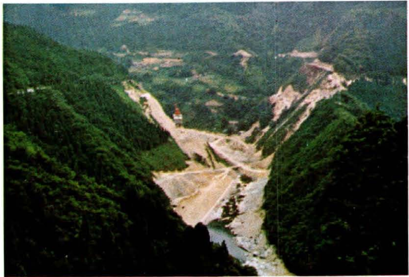
房総導水路の土砂ズイ道 (本誌54頁)
