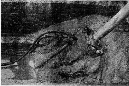
図-16 シリンダーボックス内土砂堆積状況
