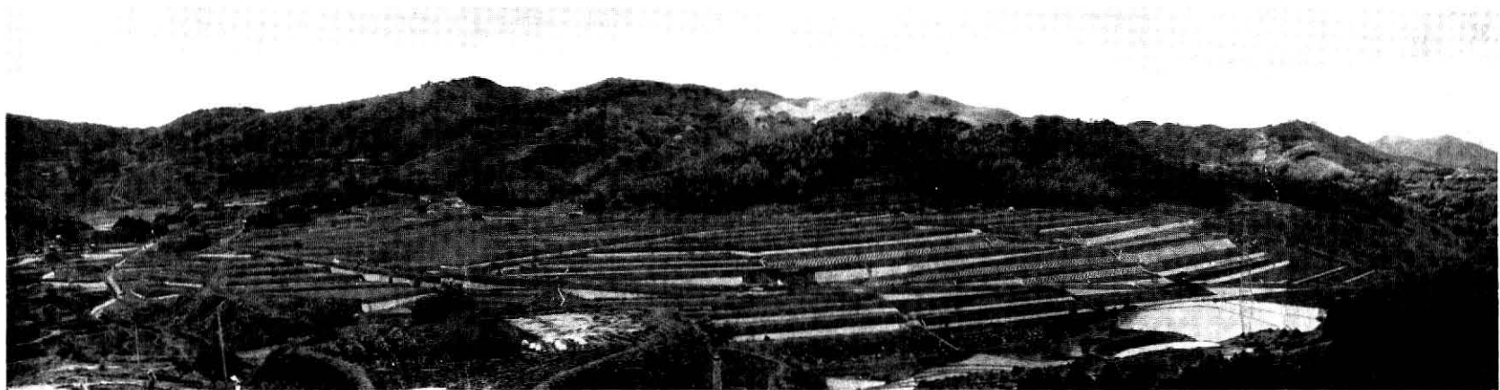
47年6月復旧全景
