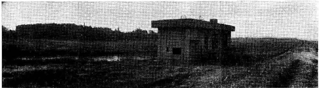
写真1-1 機場送水管路
