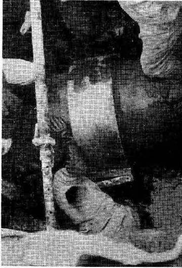
写真1-5 鋼製カラー巻立補修
