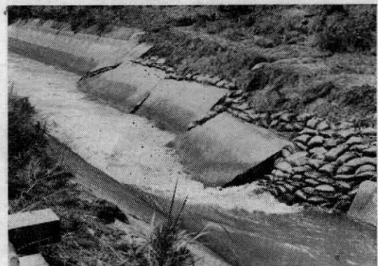
写真—17 （写—16）を拡大したもの。土のうで応急処置をし、必要量を流す。
