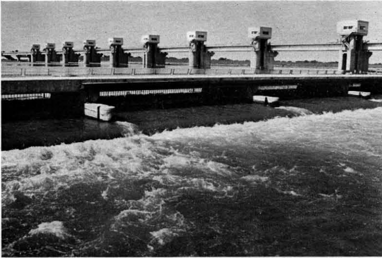
取水中の利根大堰 (右岸上流より望む)
