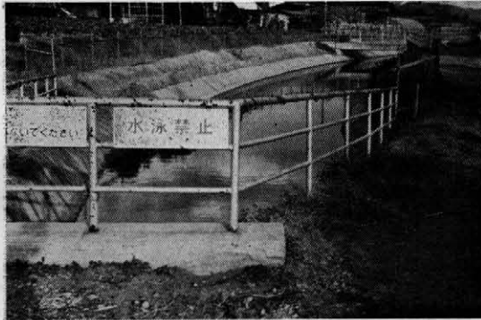
写真—3 有刺鉄線をまいたパイプ手摺
