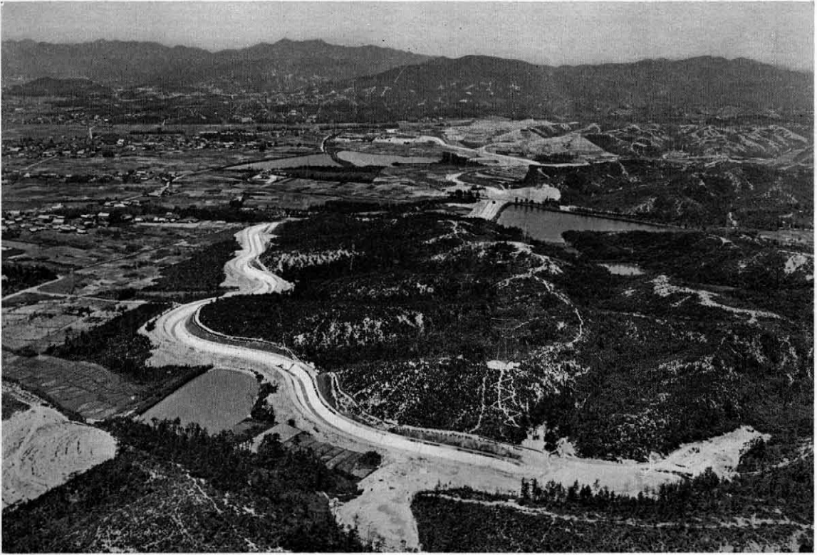
城東開水路全景
