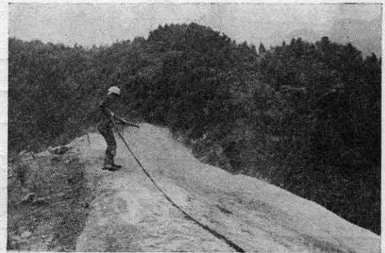
写真-7 養生剤撒布状況
