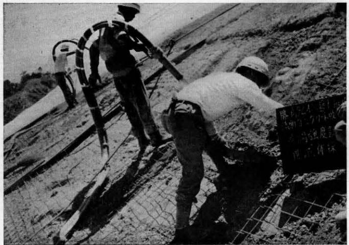
③法面コンクリート吹付作業
