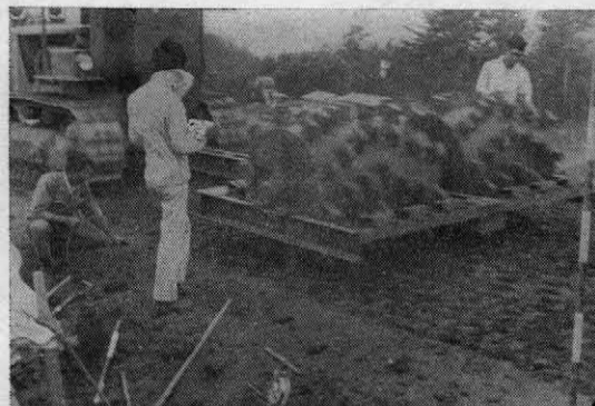
写真一三 転圧実験状況
