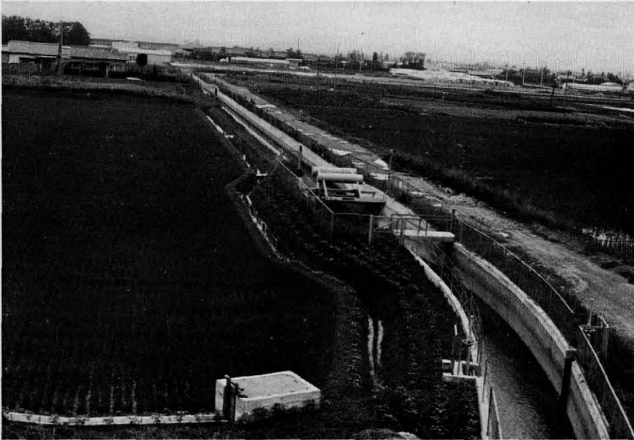
新浜名幹線水路開渠を東名高速道路地点より下流を眺む 昭和44年施行, 内巾2.8m, 高1.85m で壁厚, 底盤厚共に20cm, 流量 6,274 \text{ m}^3/\text{s} , 水深1.57m, 勾配 1/1,500 , 流速 1,432 \text{ m/s}
