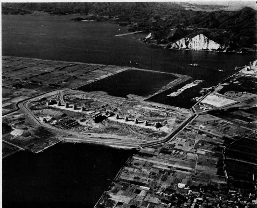
中浦水門より本庄地区を望む（本庄地区の一部）
