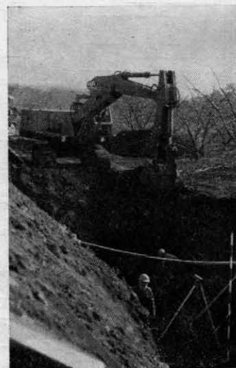
写真-1 機械掘削
