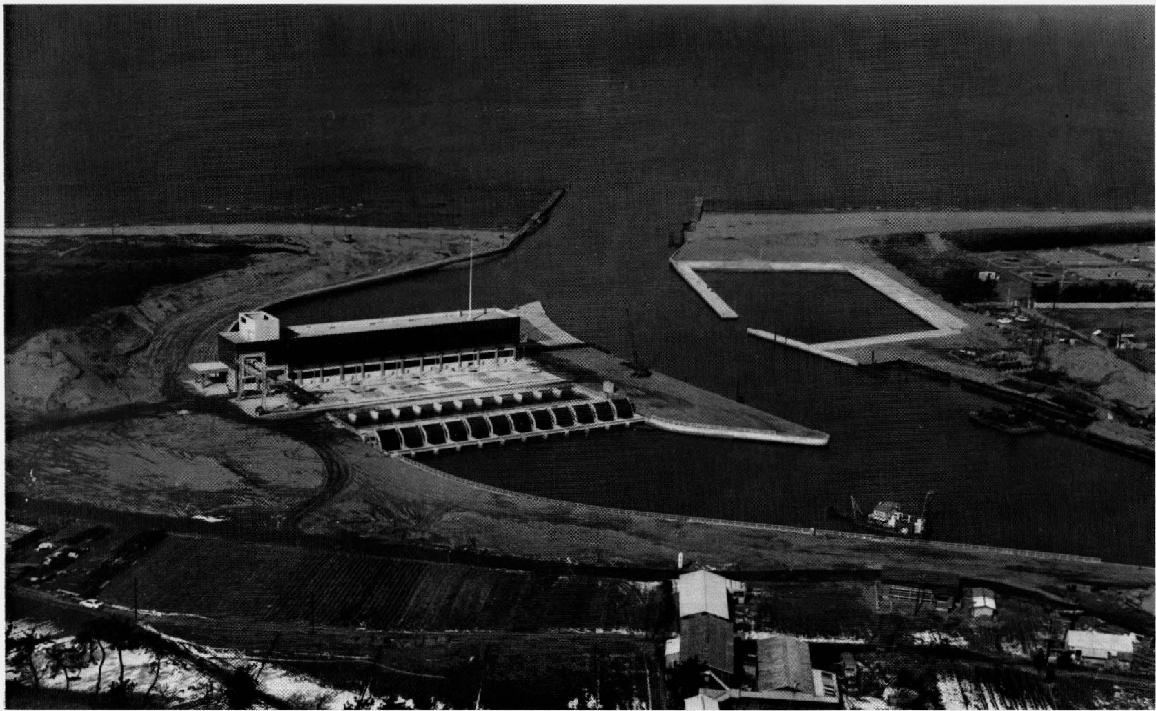
新川河口排水機場全景（上流より望む）
