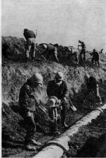
写真-2 埋戻しランマー輾圧
