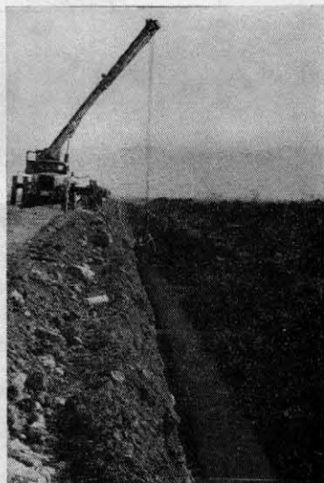
写真-3 トラッククレーンによる管布設
