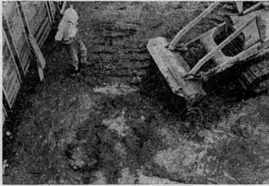
写真-9 ヘドロの混合攪拌
