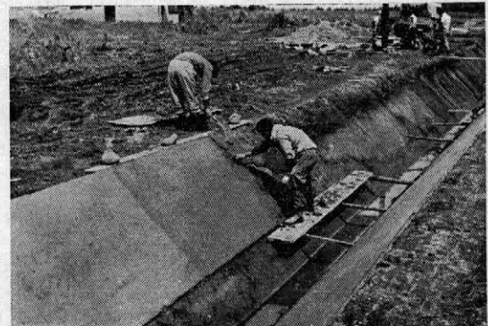
写真-7 排水路とアースライニング
