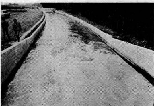
写真-2 IV型落差工の下流側付近の表面流況
