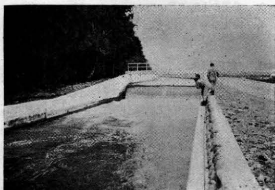
写真-1 流速測定を行なった際のIV型落差工の流況
