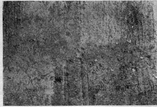
写真-10 2日後の硬化状態
