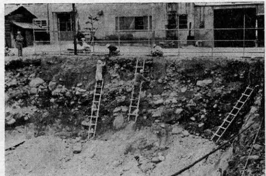
写真-8 のり面崩落防止工
