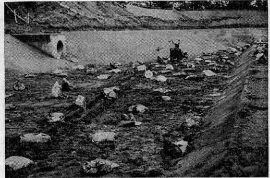
写真-6 貯水池の施工（底面）
