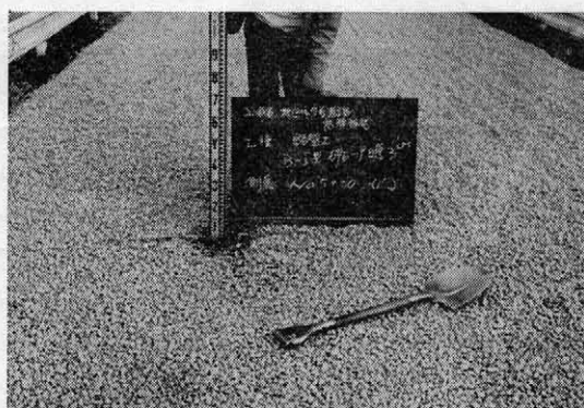
写真-3 碎石1層目(3cm)散布後
