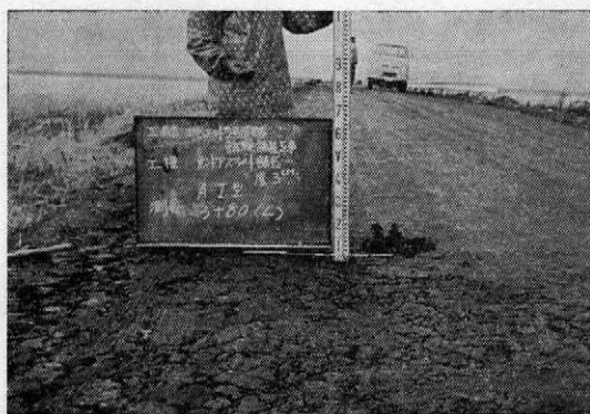
写真-2 廃材の仕上げ面
