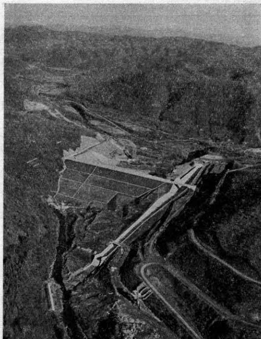
写真-1 厚真ダム全景（下流側より望む）
