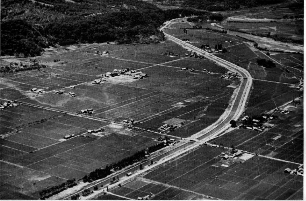
北海幹線用水路（航空写真による）
