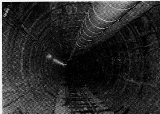
写真-6 支保工の建込みと換気パイプ
