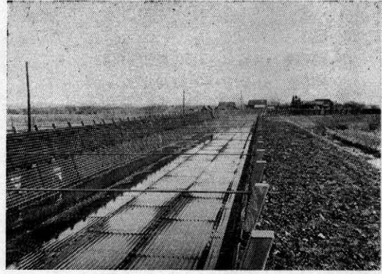
写真-2 工事完成写真(2)
