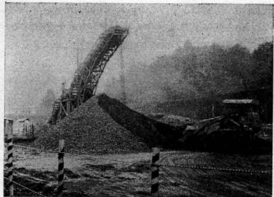
写真-5 ベルトコンベアによるズリ捨て
