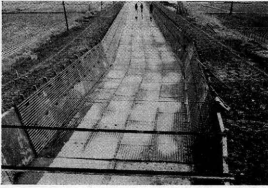
写真-1 工事完成写真(1)
